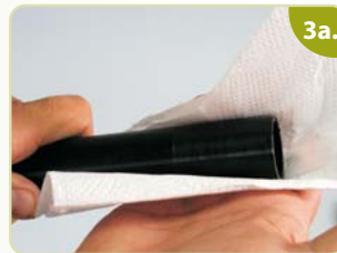
Con un papel absorbente, retirar la grasa de la tubería a fusionar, usando un agente de limpieza adecuado (isopropanol o etanol).
