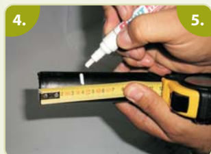
Marcar la profundidad de inserción en la tubería. Deslizar el fitting sobre la tubería hasta la marca o hasta el limitador central.
